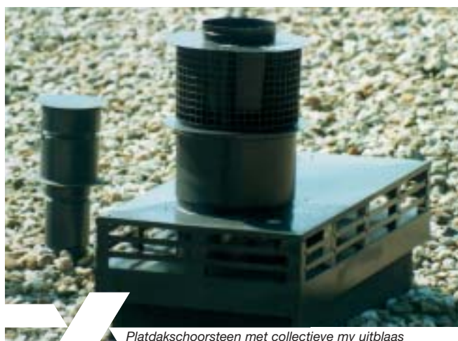
Platdakschoorsteen met collectieve mv uitblaas
