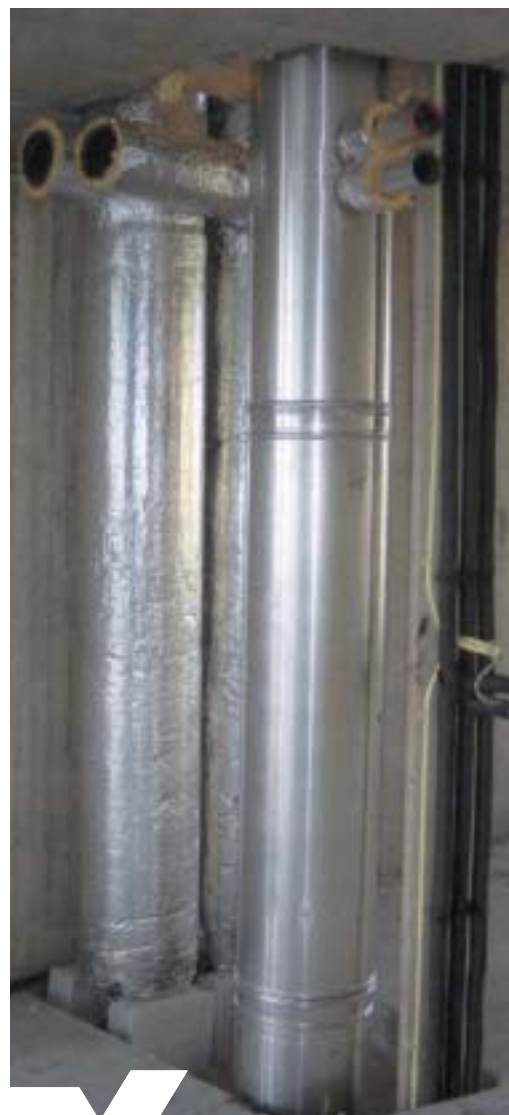
CLV + ventilatiekanalen in de ruwbouw
