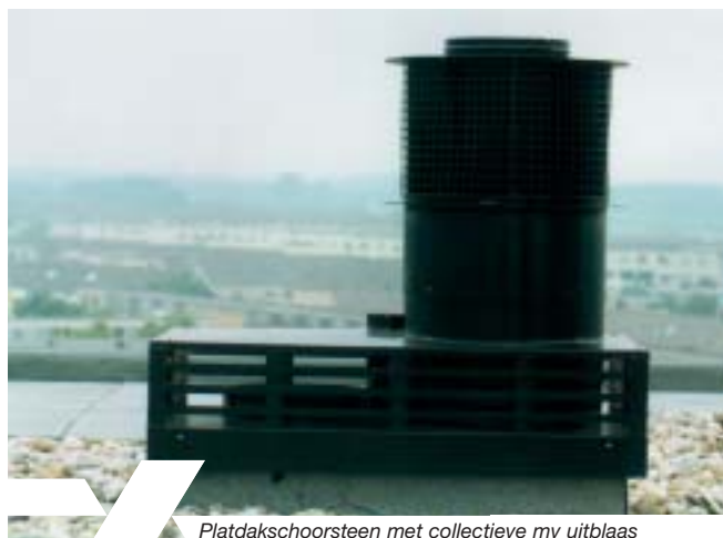
Platdakschoorsteen met collectieve mv uitblaas
